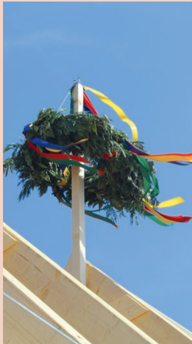
Das PTC feiert Richtfest
